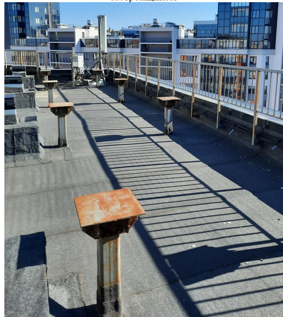
Фото закладных предусмотренных и установленных застройщиком
