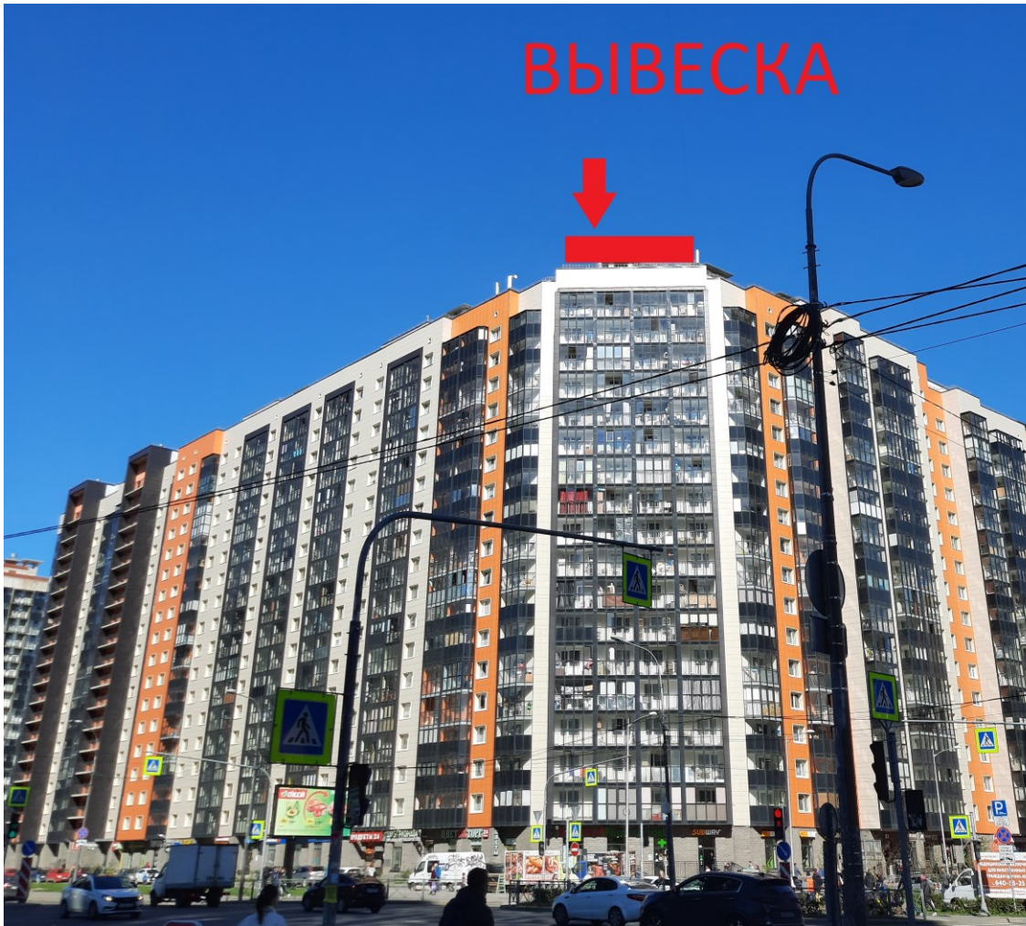
Место размещения рекламной конструкции на кровле МКД
